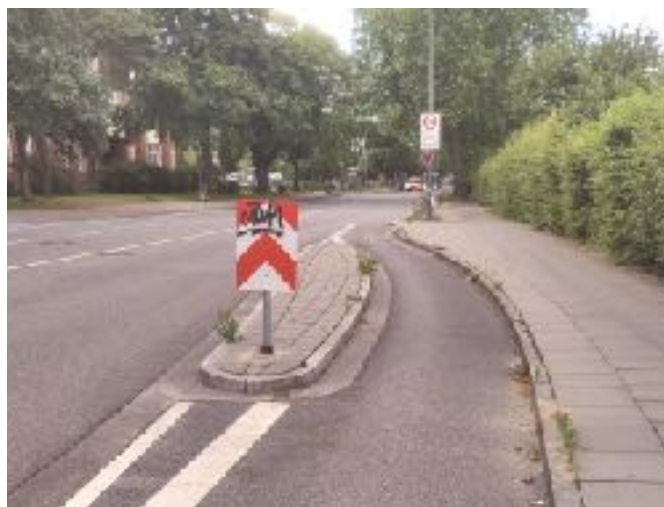
nützlich: Diese schmale Insel zwischen Radfahrstreifen und Fahrstreifen schützt an der Verengung von zwei auf einen Fahrstreifen. Eine Bake macht das Hindernis gut erkennbar. Der Durchlass für den Radverkehr ist allerdings sehr schmal. (Rübenkamp 2018) Foto: adfc hh/Andrea Kupke
