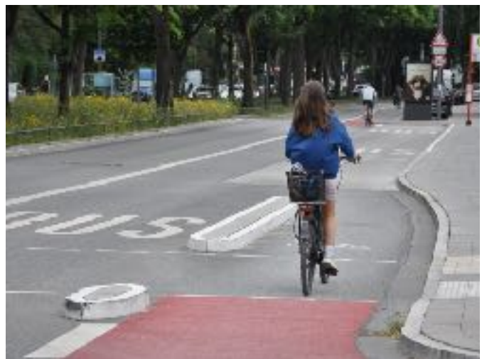
Gefährlich: Es fehlt bei den hier gezeigten Inseln an einer Kennzeichnung durch Poller, Lightboys o. ä. Bereits kurz nach Fertigstellung kam es zu Unfällen, weil die Inseln übersehen wurden. (Bleickenallee, 2022) Foto: adfc hh/Arndt Hofmann
