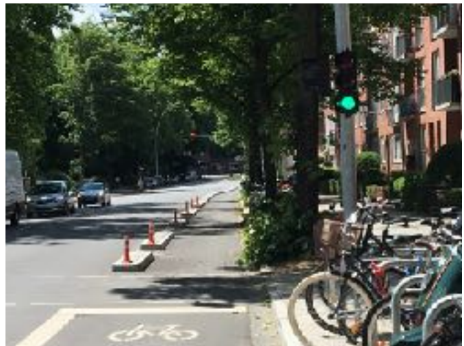
Gelungen: Inseln mit Rundpollern aus Kunststoff. Verbesserungsfähig: Bei langen Inseln (auf dem Foto im Hintergrund) sollten Poller alle paar Meter eingesetzt werden. Lange Inseln sollten außerdem ausreichend große Lücken/Durchlässe haben. (Stormarner Straße, 2022) Foto: adfc hh/Ulf Dietze
