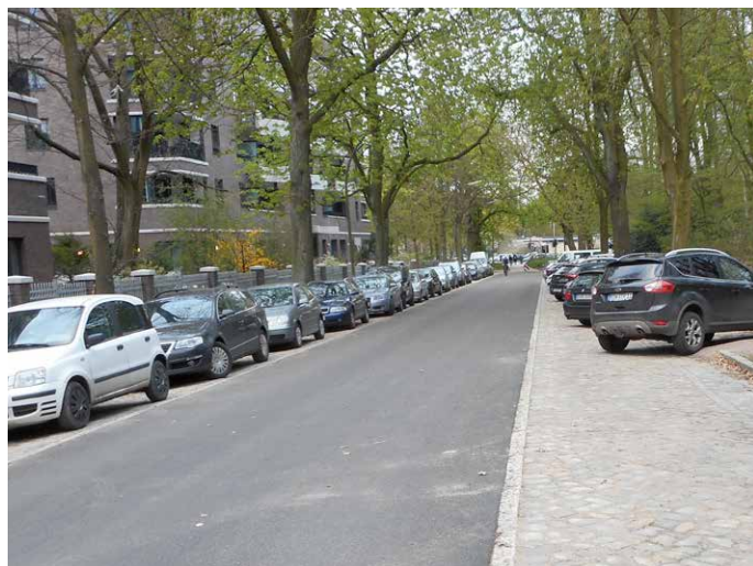
In der Frickestraße blieb historisches Pflaster am Rand für die Stellplätze erhalten. Die Kernfahrbahn wurde asphaltiert.
