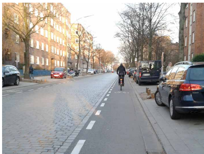
Die Hellbrookstraße sollte Kopfsteinpflaster behalten. Für den Radverkehr wurden Schutzstreifen asphaltiert.
