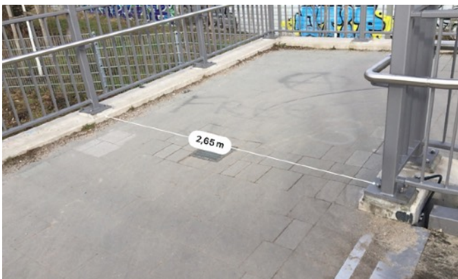
Am Wendepunkt ist die Rampe lediglich 2,65 m breit. Der Abstand zwischen den parallelen Rampenteilen beträgt ca. 75 cm. (Foto: adfc hh/Ulf Dietze)
