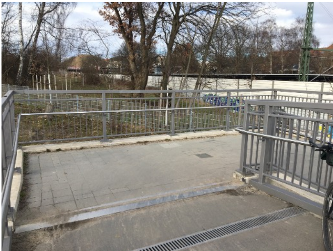
Die Rampen sind 3,15 m breit. (Foto: adfc hh/Ulf Dietze)
