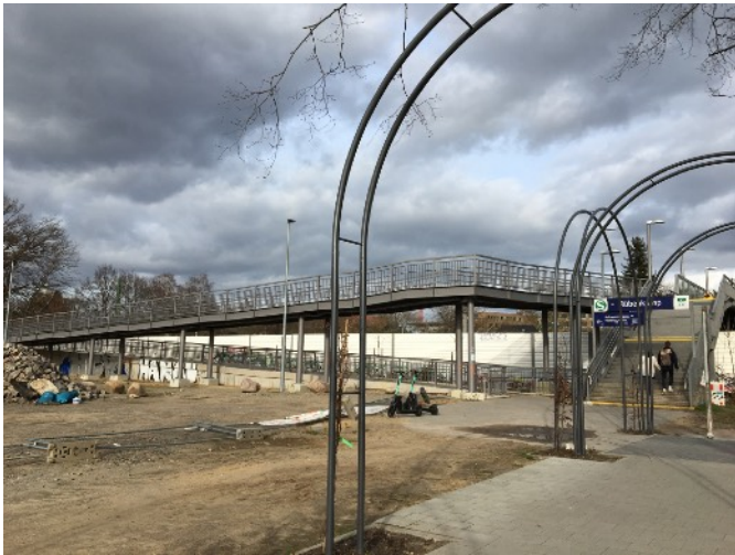
Nachträglich ergänzte Rampe am S-Rübenkamp, Südseite des Bahnsteigs, westlicher Zugang. (Foto: adfc hh/Ulf Dietze)
