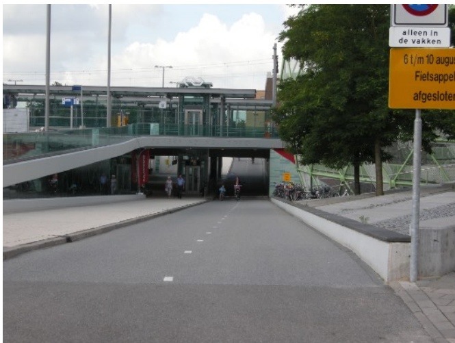
Beispiel einer geradlinig geführten Fahrrad-/Fußverkehrs-Unterführung mit Zugang zum Bahnhof via Rampe und Fahrstuhl. (Foto: adfc hh/Ulf Dietze, Alphen aan den Rijn/Niederlande)
