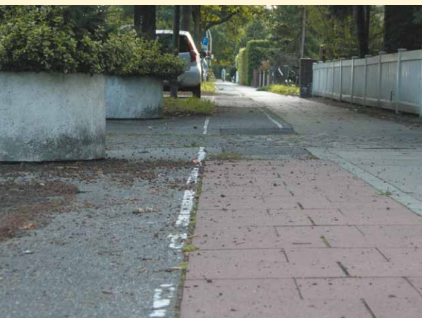
Die Wiederherstellung der Radwege nach privaten Bauvorhaben oder Tiefbauarbeiten der Versorger gibt den Wegen dann den Rest: ein Flickenteppich unterschiedlicher Oberflächen, unterschiedlicher Längs- und Querneigungen, mangelhafte Verlegetechnik. – Viel Geld für sehr schlechte Radverkehrs-Infrastruktur.
