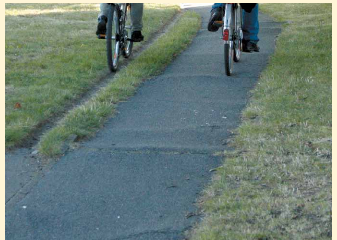
Nach wenigen Jahren – manchmal schon nach Monaten – zeigt die Oberfläche erste Verwerfungen. Die Fahrt wird unattraktiv und zunehmend unsicher.
