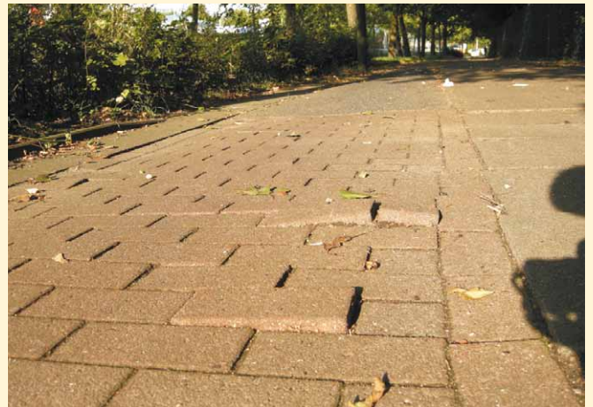
Nach wenigen Jahren – manchmal schon nach Monaten – zeigt die Oberfläche erste Verwerfungen. Die Fahrt wird unattraktiv und zunehmend unsicher.
