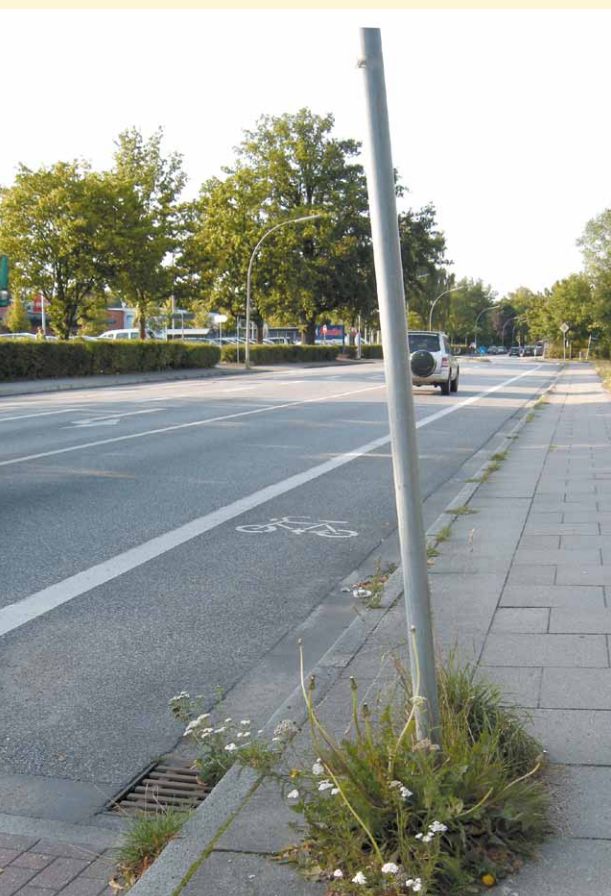
Die Wiederherstellung der Radwege nach privaten Bauvorhaben oder Tiefbauarbeiten der Versorger gibt den Wegen dann den Rest: ein Flickenteppich unterschiedlicher Oberflächen, unterschiedlicher Längs- und Querneigungen, mangelhafte Verlegetechnik. – Viel Geld für sehr schlechte Radverkehrs-Infrastruktur.
